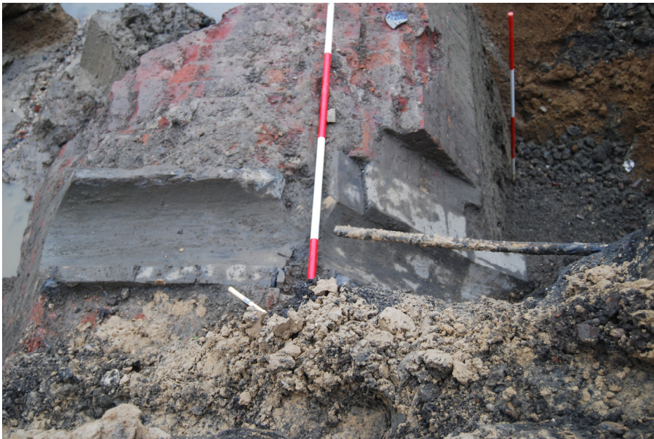
Afb. 3.4 Bovenzijde van de muur met het sluisje.
